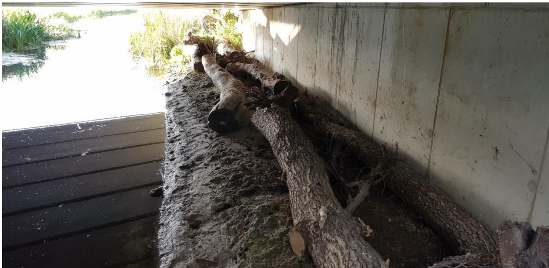
Foto 3.1 Faunapassage 24b Burgumerfeansterfeart was ook in 2018 nog niet optimaal ingericht (loopstrook nog geblokkeerd door stobben en stammen) en daardoor nog niet geschikt voor gebruik door enkele van de doelsoorten.
